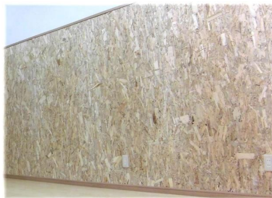
事務所内装壁
