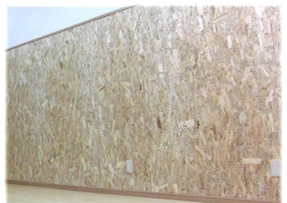
事務所内装壁
